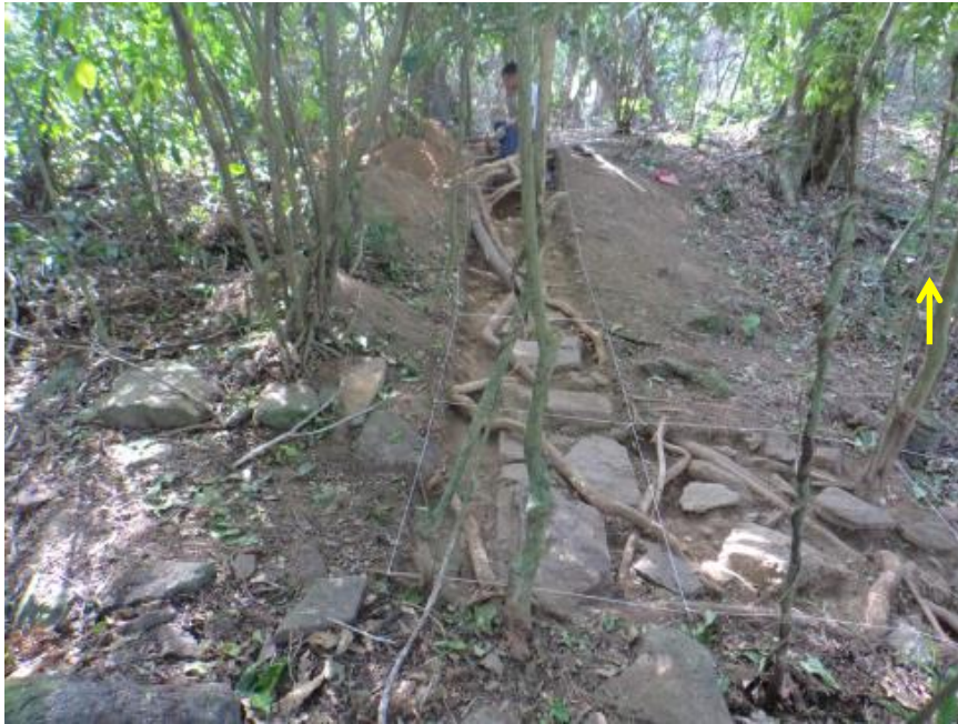
Muro evidenciado na elevação abrupta do terreno (CML2 / T1) (seta amarela indica o Norte)
